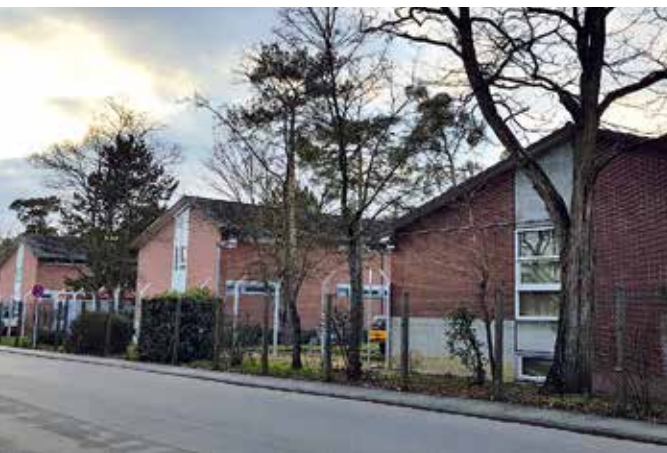
Hier entsteht die neue Abschiebehäfteinrichtung für Hessen.
